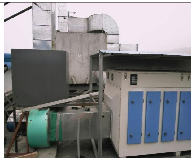
整改后加装UV光解+活性炭吸附塔处置废气
