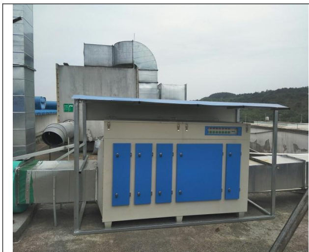
整改前只有UV光解设备处置废气
