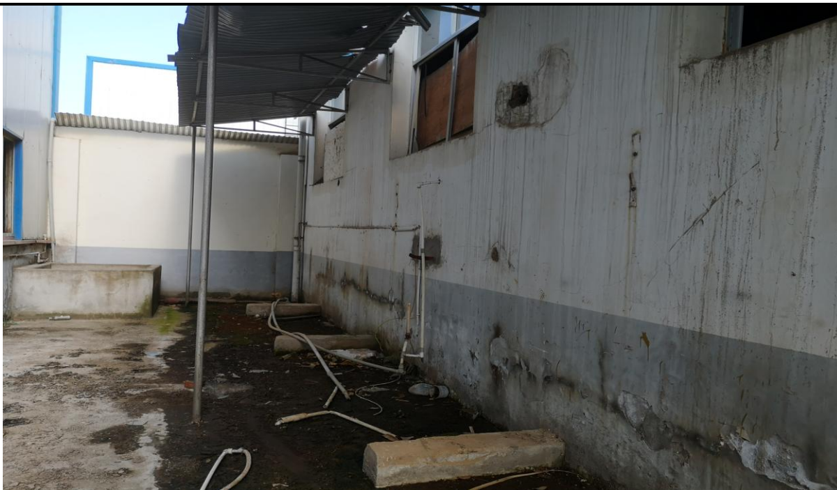
原液氨罐暂存区域（已拆除）
